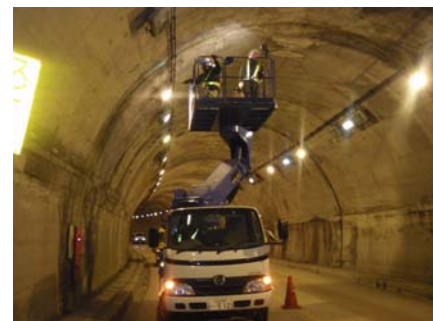
図-1 トンネルの点検方法(従来)
