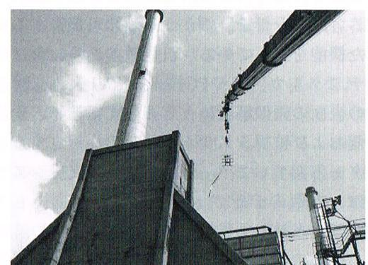
写真5 投入状況 (地上より高さ約30m・ブーム長60m)
